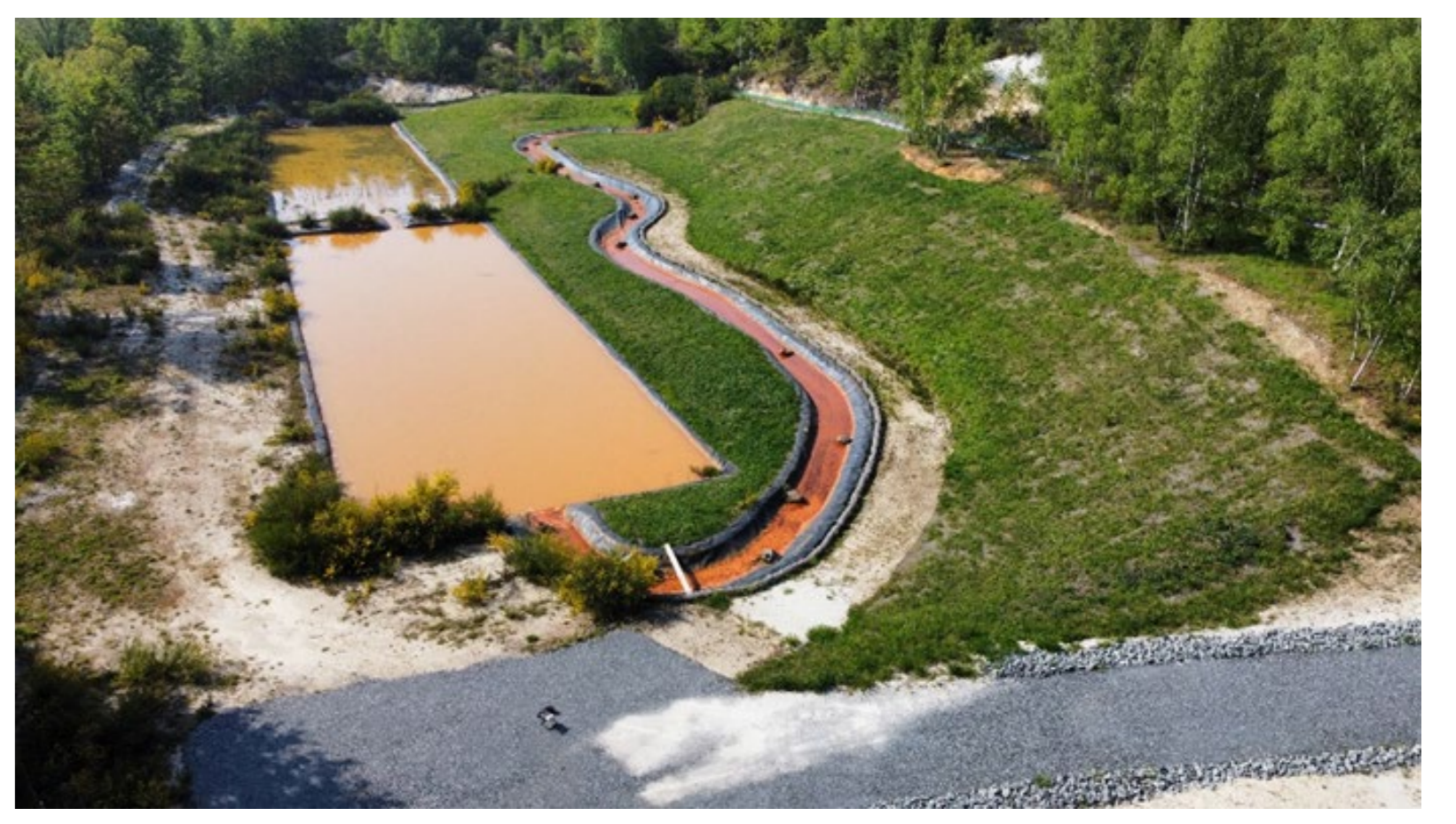
Exemple de traitement passif par lagunes (La Bellière, 49)
