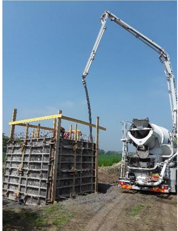
**3<sup>ème</sup> étape** : Retrait des banches avec ferrailage en attente pour liaisonner la partie inférieure du poste (visible sur les photos) avec la partie supérieure (à créer).
