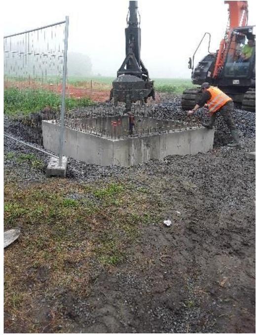
**6<sup>ème</sup> étape** : Réalisation du radier et de la dalle de couverture, pose des équipements et des aménagements extérieurs
