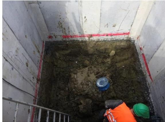
**4<sup>ème</sup> étape** : Opération d'excavation des terres intérieures et descente progressive du poste.
