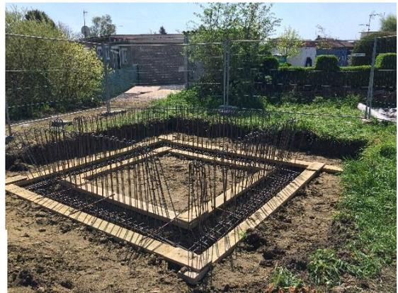
**2<sup>ème</sup> étape** : Ferrailage et coulage du béton des parois du poste (partie inférieure)
