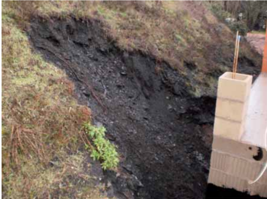
Étude du bassin houiller de Graissessac (34) : construction en pied immédiat d'un petit terril situé en contexte périurbain
