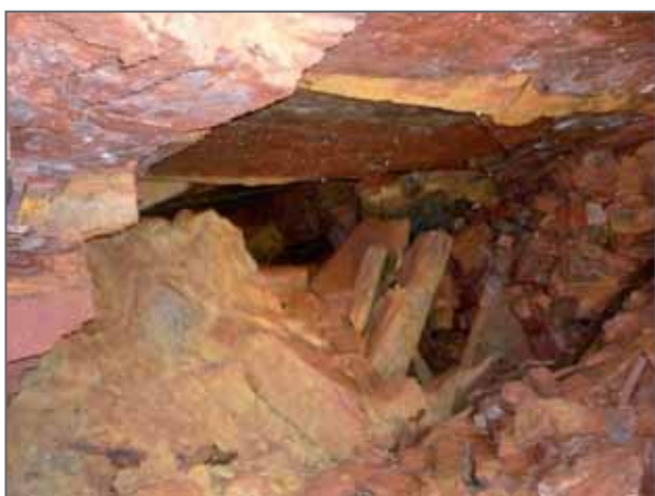
Étude des mines de fer de Privas (07) : éboulement du toit dans un élargissement
