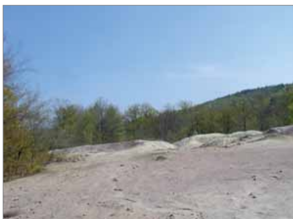
Réalisation d'une carte informative pour l'établissement d'un PPRM : dépôts de résidus de traitement minier à Vaulry (87)
