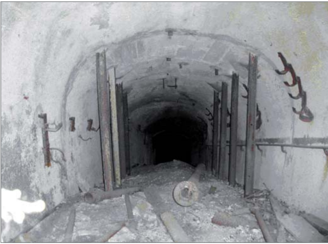
Descenderie de la mine de lignite de Saint-Zacharie foncée en 1940 (Var)
