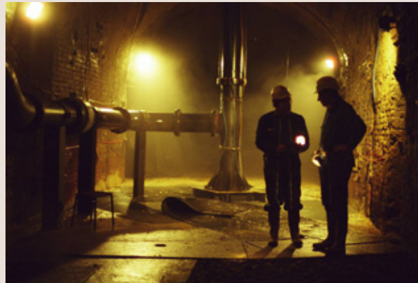
Ancien puits d'exhaure du bassin ferrifère lorrain (puits d'Havange), aujourd'hui reconverti en point de débordement des mines ennoyées (réservoir Nord).
