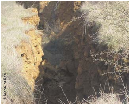
Crevasse suite à un mouvement. Affaissement différentiel.
