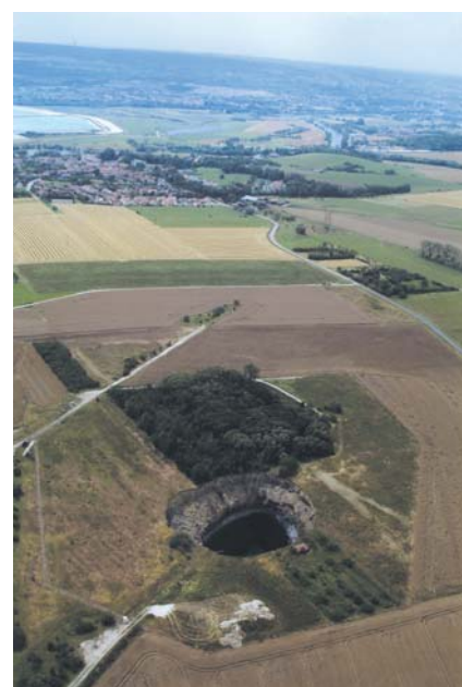
Effondrement, la Râpe, Meurthe et Moselle.
