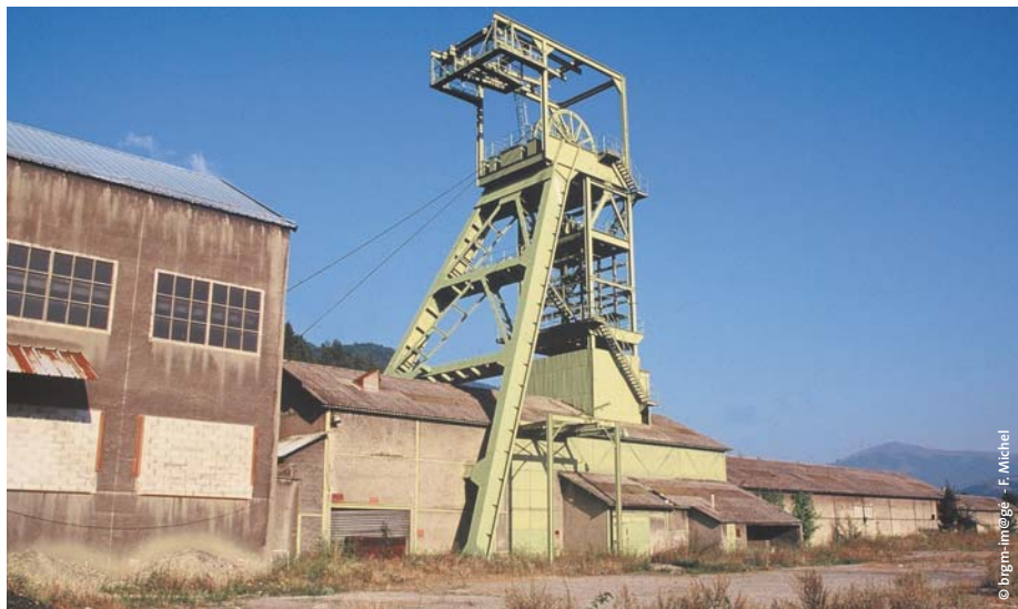
Après-mine - chevalement à l'abandon.
